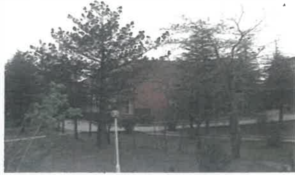
Binanın 2009 yılındaki durumu
