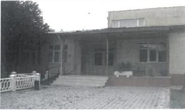
Binanın 2009 yılındaki durumu
